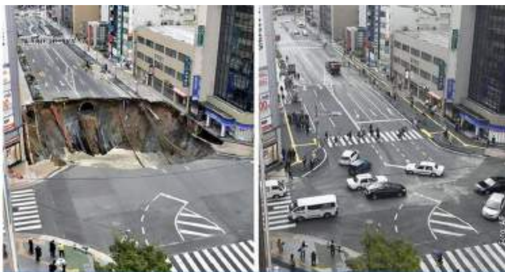
Slika 3.13. Rupa koja se pre nedelju dana otvorila nasred prometne ulice u japanskom gradu Fukuoka, široka skoro 30 metara u prečniku, potpuno je sanirana nakon samo dva dana, a za nedelju dana ulica je puštena u promet
